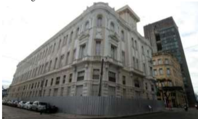
Figura 1 – Vista do edifício Chanteclair.
