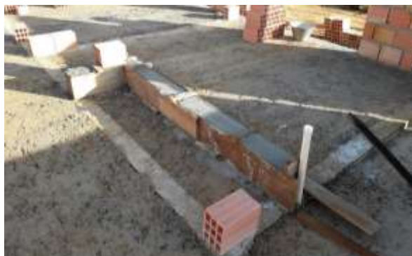
Figura 2 – Incompatibilidades entre projetos estrutural e arquitetônico
