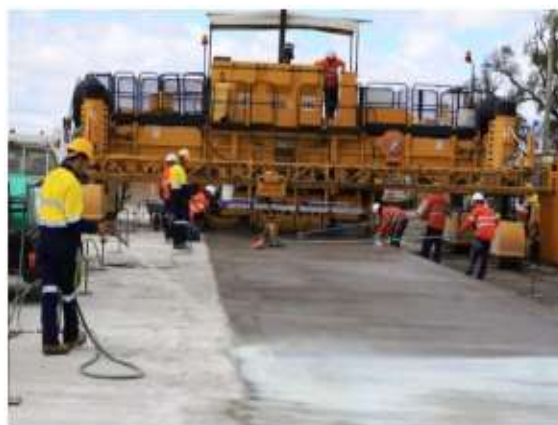
Figura 4 – Obras de Pavimentação no BWWA
