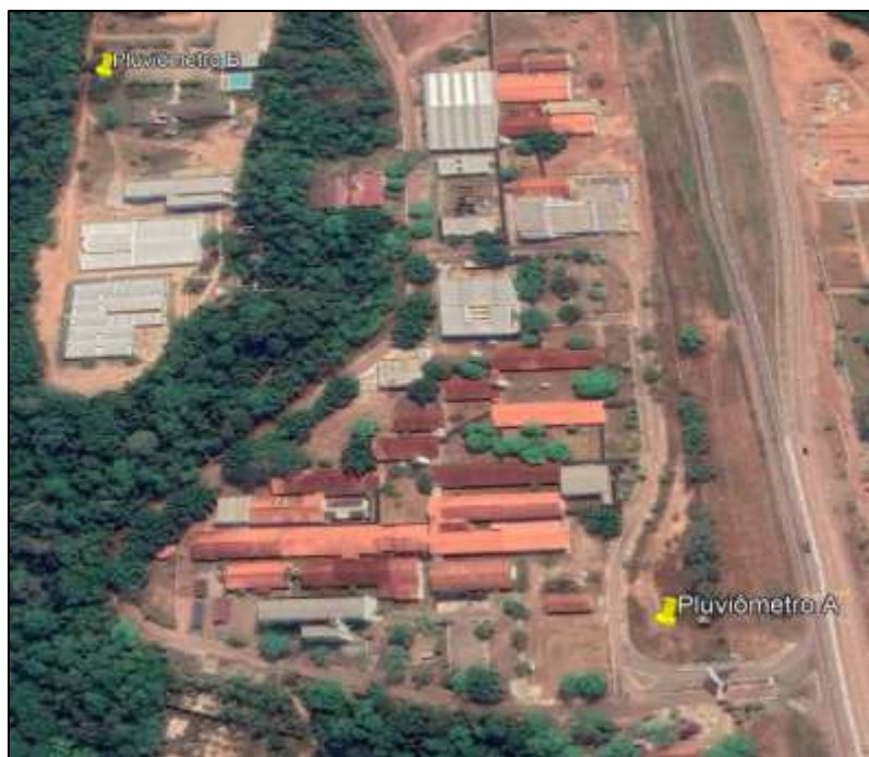
Figura 1 – Área de instalação dos pluviômetros.
