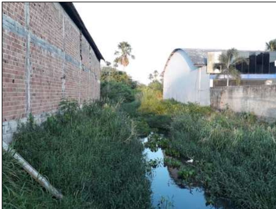
Figura 3 - Imóveis não residenciais sobre a margem do rio.
