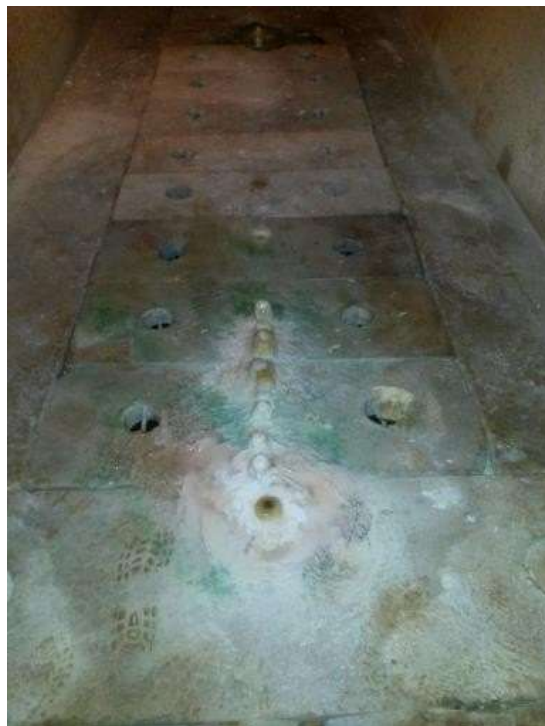
Figura 4 - Formação de estalagmites – UHE-Tucuruí
