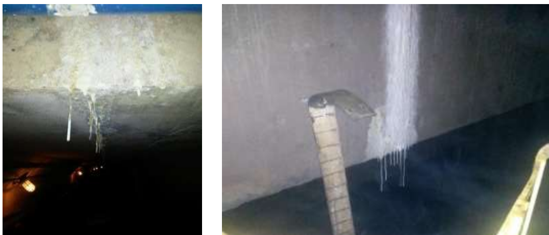
Figura 3 - Formação de estalactite – UHE-Tucuruí
