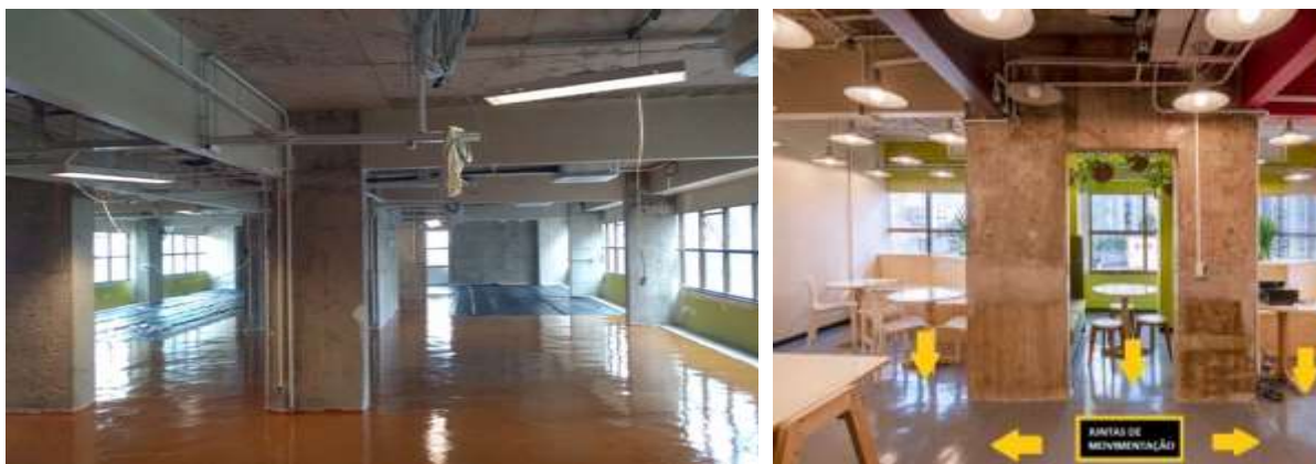
Figura 10 - Resultado do piso epóxi instalado: (a) vista geral e (b) detalhes das juntas de movimentação
