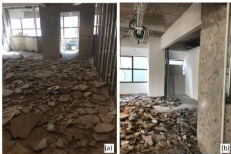
Figura 5 - (a) Demolição do contrapiso original, e (b) remoção do material do contrapiso
