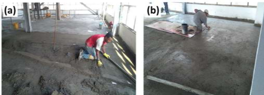
Figura 8 - (a) Sarrafeamento, (b) uso da desempenadeira para acabamento
