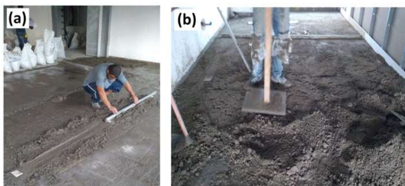
Figura 7 - (a) Execução das mestras, (b) compactação da argamassa
