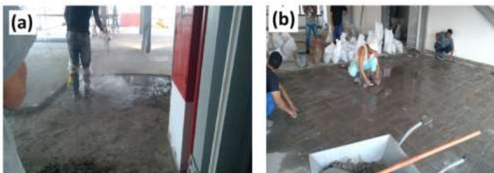
Figura 6 - (a) Polvilhamento de cimento, e (b) execução das taliscas
