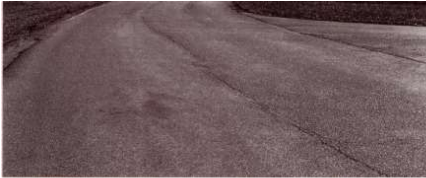
Figura 3 - Trincas longitudinais
