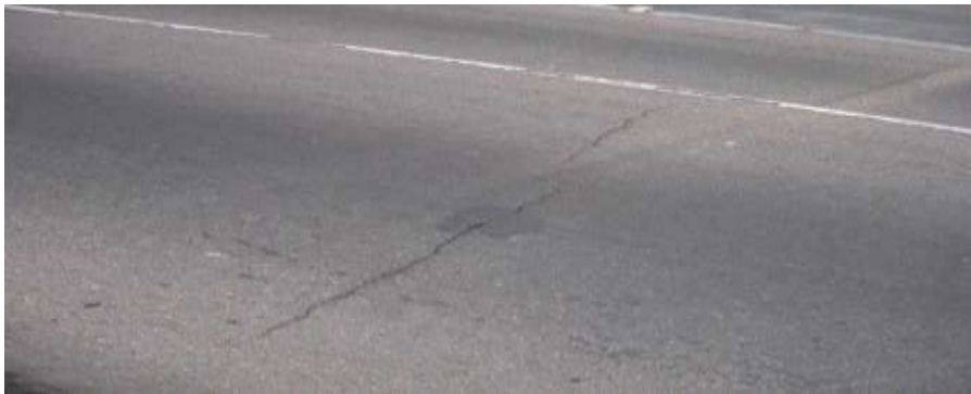
Figura 4 - Trinca transversal
